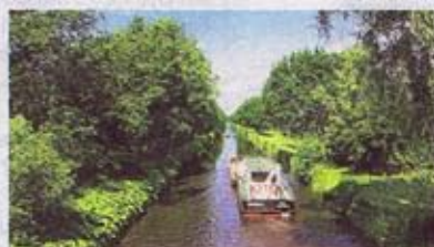
Störkanal Richtung Mittelschleuse
