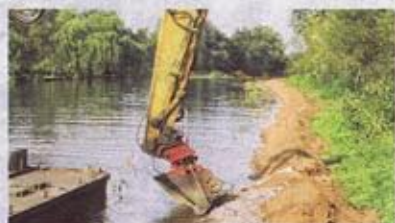
Erste Dammsanierung 90er Jahre
